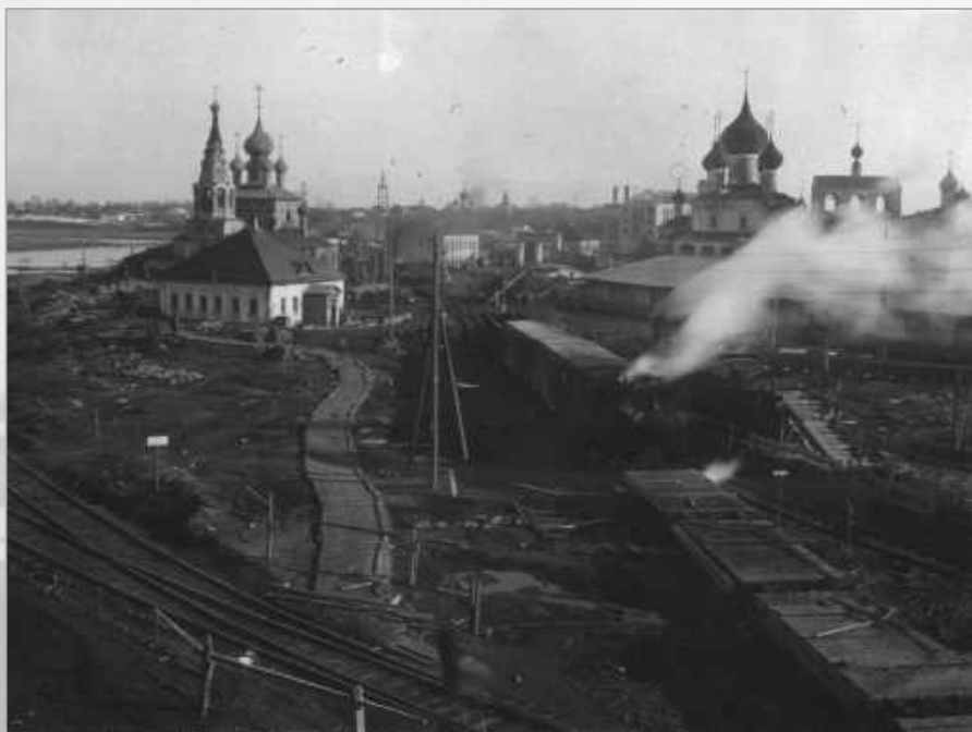
Строительная площадка Угличской ГЭС
